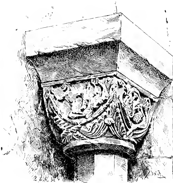
FIG. 165. — Chapiteau cubique sculpté au portail de l'église d'Hasprès (Nord).
